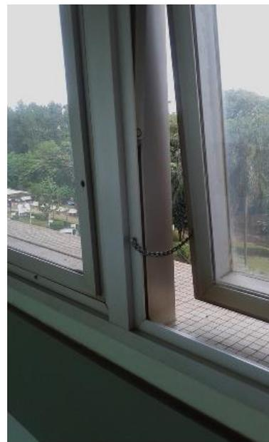
*Figura 5. Detalhamento da instalação dos limitadores de janelas para evitar a entrada de pombos domésticos no hospital. Ribeirão Preto, 2016.*
