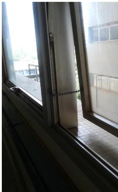
*Figura 4. Limitador de abertura de janela instalado com corrente e parafuso. Ribeirão Preto, 2016*
